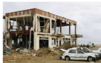
津波で壊滅的な被害を受けた「常磐山元自動車学校」の校舎（11年4月、宮城県山元町）
