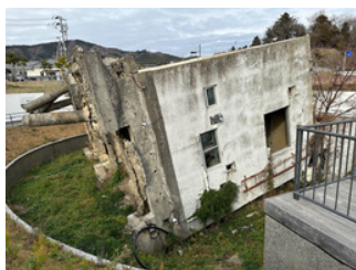
② 鉄筋コンクリートが津波の威力で倒された姿
